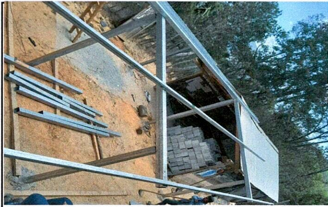
Foto 1: CUBIERTA DE LAMINA
